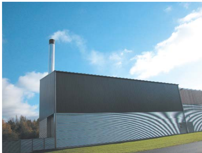
- Chaufferie paille - Photo CEA
