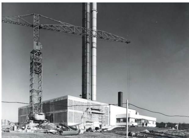
- Extension du bâtiment - Photos CEA
